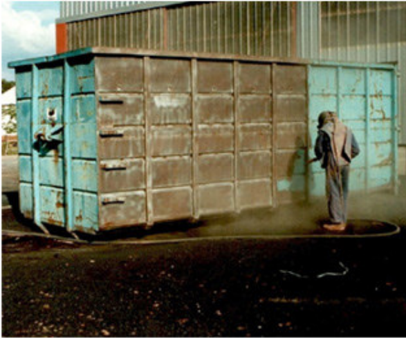
Sablage d'un caisson
